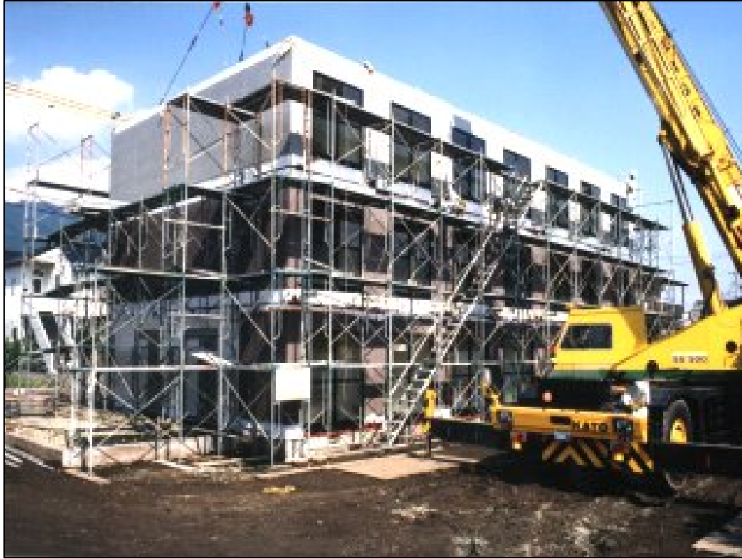
顧客現場でのモジュール ユニットの積み下ろし
