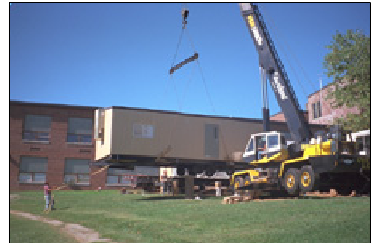
顧客現場でのモジュール ユニットの積み下ろし
