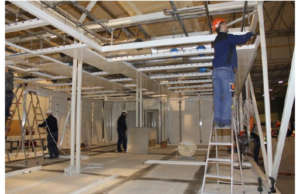
クリーンルームパネル固定
